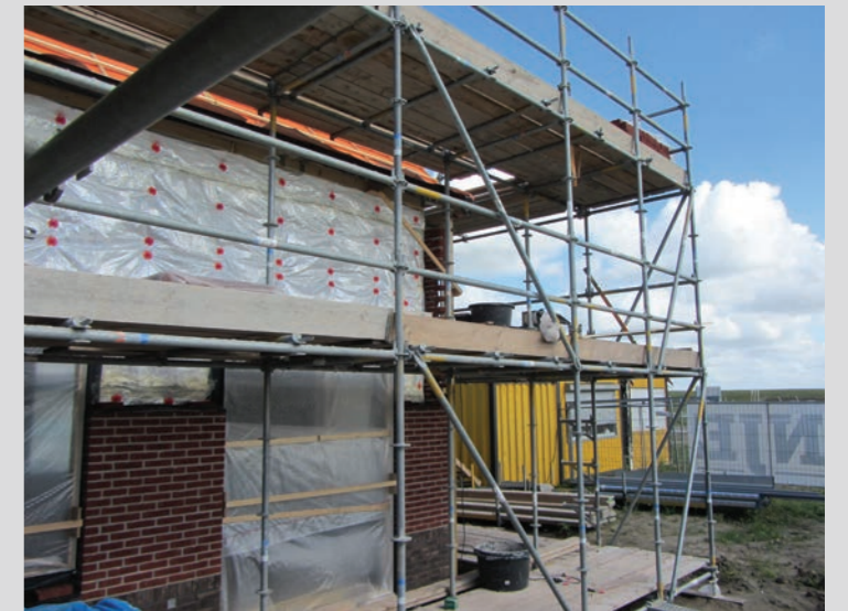
Spouwisolatie bij nieuwbouwwoningen
