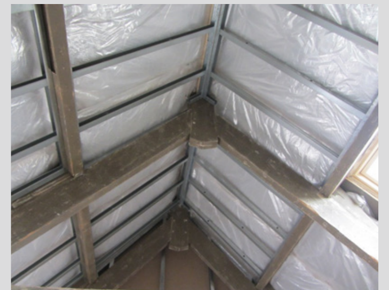
Bij dakisolatie met metalstud blijven authentieke dakbalken zichtbaar
