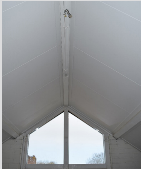
Zolders in één dag isoleren met het Isobooster Hellend dak Systeem (HDS)
