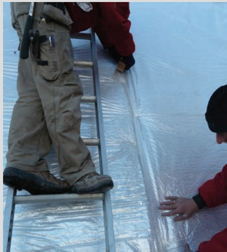
Banen onderling vastzetten met tape
